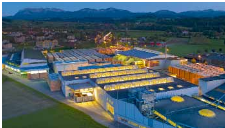
In Buttisholz liegt die Tschopp Holzindustrie – das integrierte Säge-, Schalungsplatten- und Pelletswerk ist der sauberste Betrieb, den der Autor in seiner mehrjährigen Redaktionstätigkeit je besucht hat
